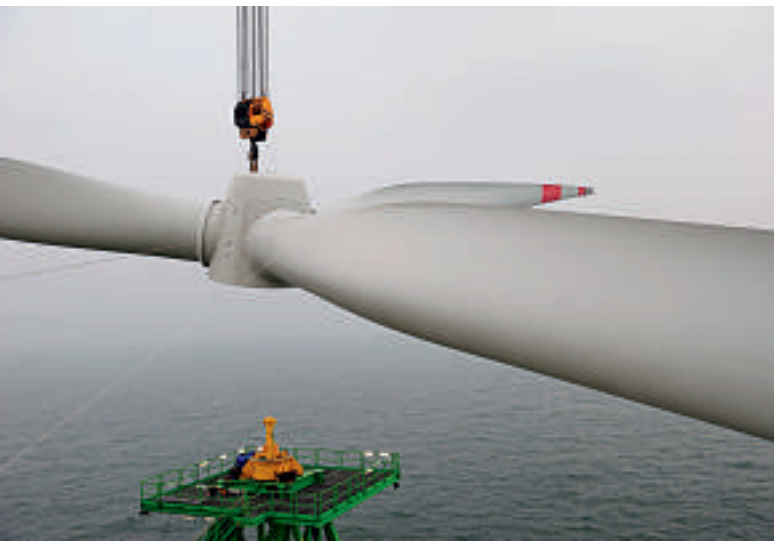
Montage eines mehr als 100 Tonnen schweren Rotorsterns
